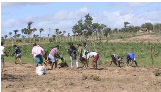
Figura 3. Oficinas de Construção da Unidade de Aprendizagem (UA) da Comunidade de Caqueiro I, em Canidé do São Francisco, Sergipe, 2013.
